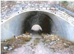
O 'loboduto' visto por dentro (as pedras fazem parte do projecto) e tal como se observa a partir do quilómetro 58 da A24. Em baixo, uma das passagens inferiores para a fauna, em que foram colocadas plantas sobre um pavimento de betão
