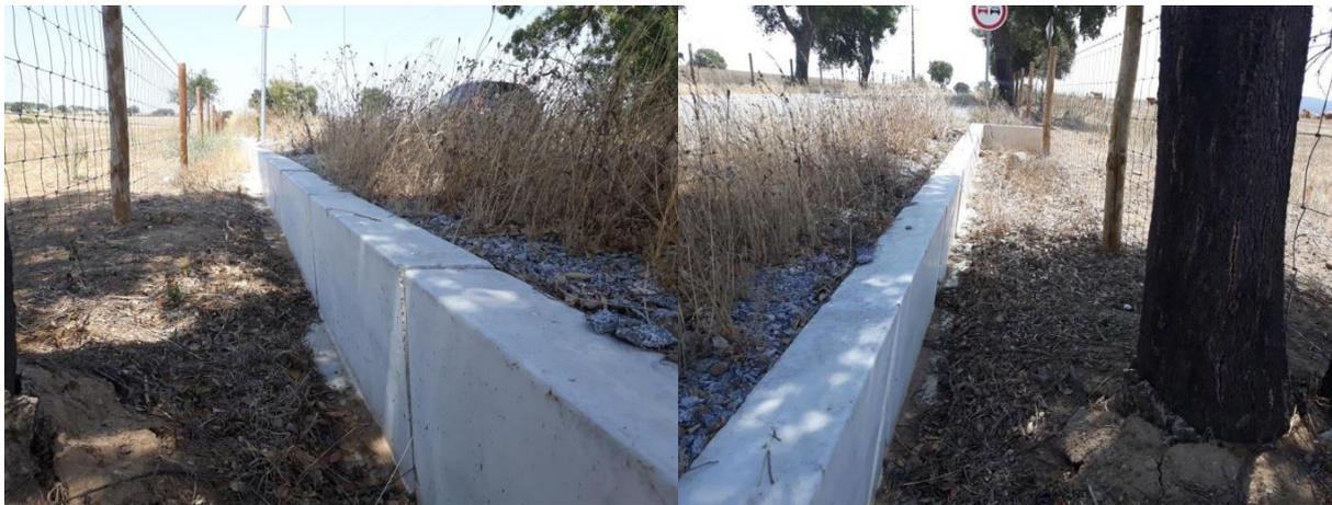
**Figura 9** – Barreiras colocadas ao longo da estrada; com destaque para o pormenor da construção em que o topo das barreiras está ao nível da estrada.
